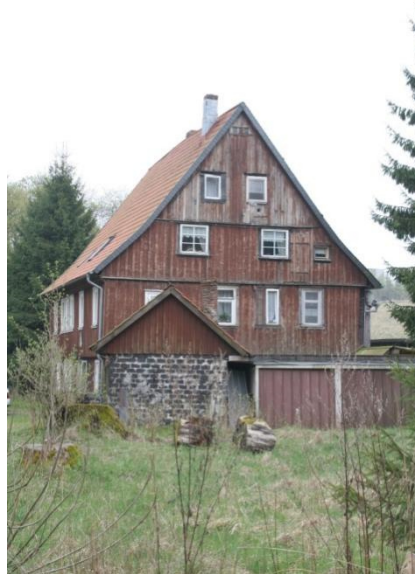
Abb. 7: Ludwiger Zechenhaus an der Altenauer Straße, Clausthal. Die angebaute Schmiede ist aus Schlackensteinen der Clausthaler Bleihütte gefertigt. (Foto Anja Schmid-Engbrodt).
