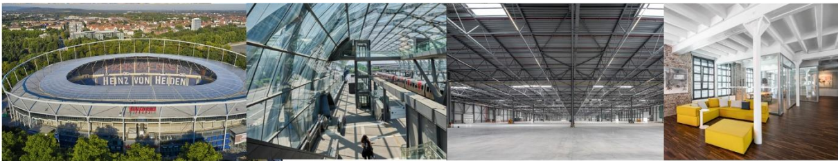
Abbildung 2.2: Anwendungsbeispiele für reaktive Brandschutzsysteme auf Stahlbauteilen (v.l.n.r.): Heinz von Heiden Arena in Hannover (Foto: Ulrich Stamm), U-/ S-Bahnhaltstelle Elbbrücken in Hamburg (Foto: Sika Deutschland GmbH), Lagerhalle einer Logistikfirma in Lüttich (Foto: Tom Bauer), denkmalgeschütztes Industriegebäude nach Umnutzung als Bürogebäude in Wuppertal (Foto: Tom Bauer)
