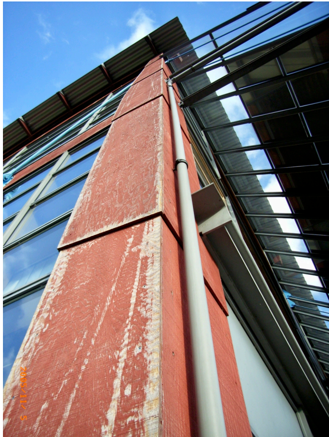
Verkleidung der äußeren Pylonstützen mit Sperrholzplatten, Status November 2003
