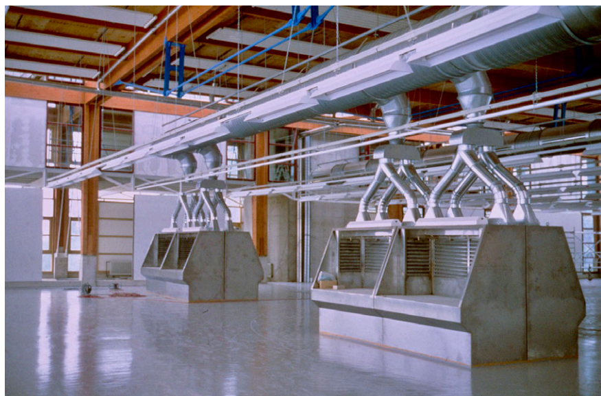
Halle 7 mit Digestorien für Klebearbeiten, Status November 1992
