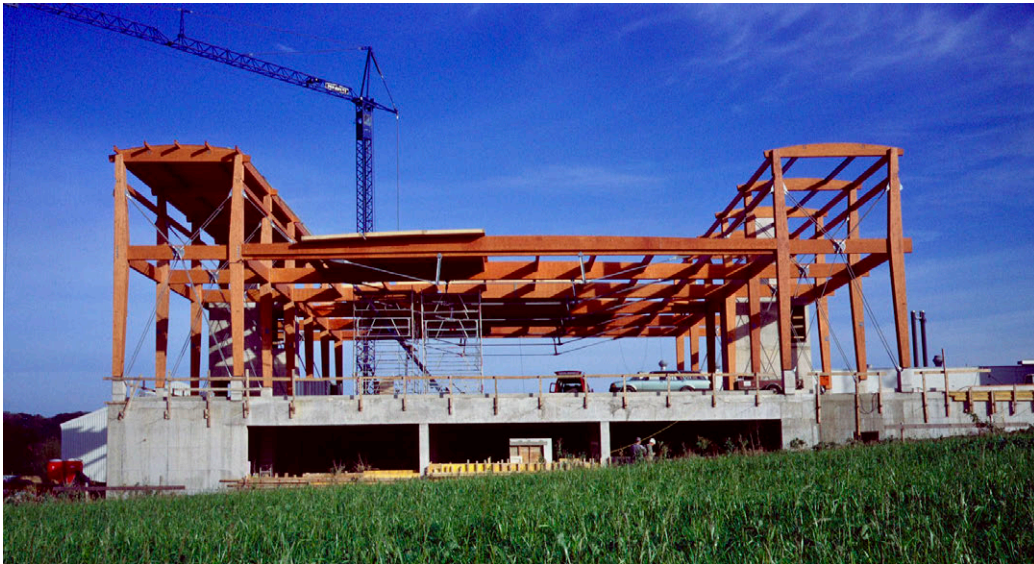
Baustelle im Oktober 1990, links der Nordpylon mit montierter Dachkonstruktion
