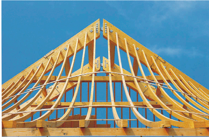
Baustelle Pavillon 3 mit gespreiztem Binder, Hängerippen u. horizontalem Pfettenrahmen, Status Juli 1987
