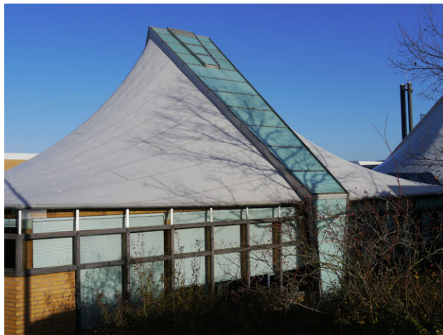
Pavillon 3, Nachrüstung transluzenter Folien auf den Gläsern der Dachfenster 1991. Foto v. 2019
