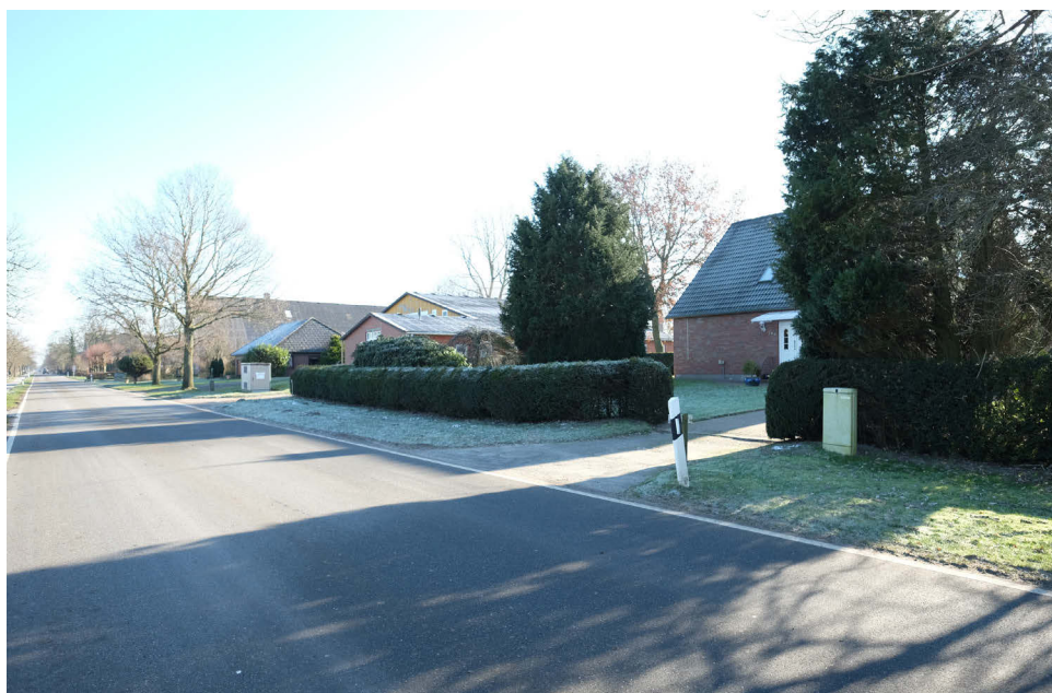
4-13 (oben) – Einfamilienhaus (Nr. 4). Lüder, 2018. 4-14 (unten) – Einfamilienhaus (Nr. 5). Lüder, 2018.
