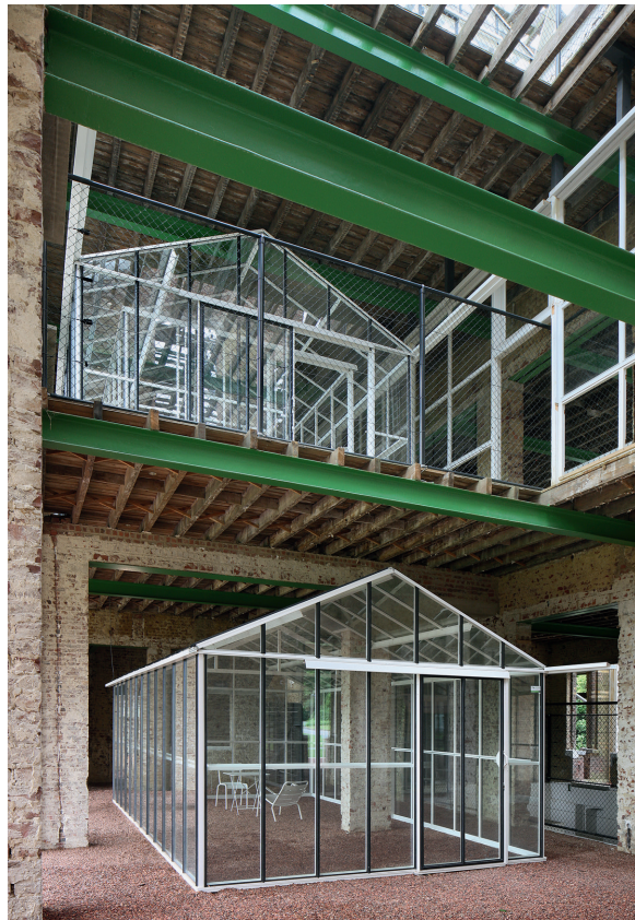
15-16 | Architekten De Vylder Vinck Taillieu / Filip Dujardin PC Caritas Melle 2015
