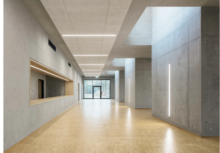
Foyer der Mehrzweckhalle der BBS Neustadt 2018, Fotograf: Frank Aussieker
