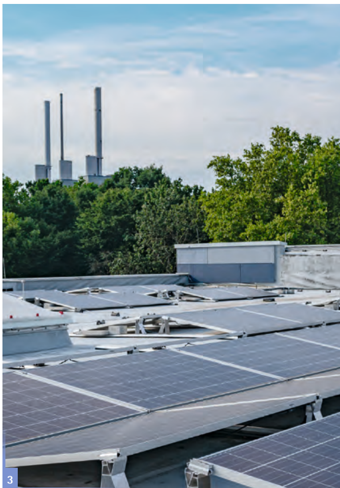
Abbildung 3 Erste Schritte bei der Stromerzeugung durch Photovoltaik: Drei neue Anlagen entstehen auf Dächern von Gebäuden in der Appelstraße, der Strom fließt überwiegend ins uneigene Stromnetz, so werden rund 90 Tonnen CO 2 Ausstoß jährlich vermieden. Auf den Gebäuden der Leibniz Universität gibt es noch ein großes Potenzial für PV Anlagen. Quelle: LUH
