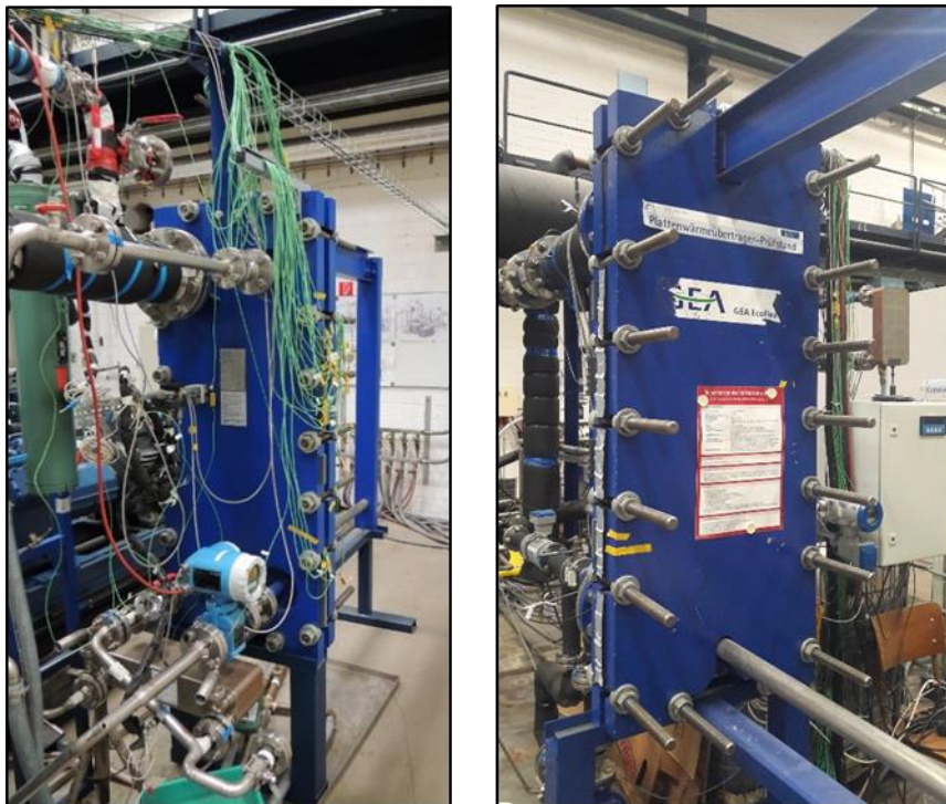
Abbildung 6.1: Versuchswärmeübertrager mit installierten Thermoelementen; Rechts: Kondensator; Links: Verdampfer
