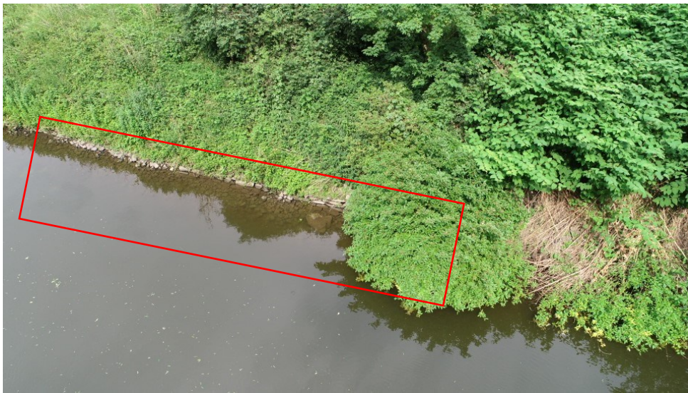
Abb. 16: Luftbildaufnahme an der Lahn mit rot markierter Ufersicherung aus Steinen
