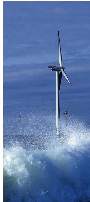
Abb. 1-1. a) Belastungen und Bezeichnungen nach BSH-Standard 6 ; b) Offshore-Windpark Horns Rev (DK), 2 MW-Turbine auf Monopile, Quelle: Vestas
