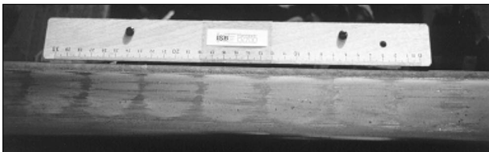
**Bild 2.11:** Schlupfwellen auf einer Innenbogenschiene
