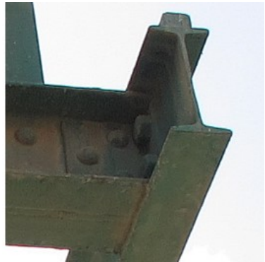
Abbildung 2: Radarreflektor für das Langzeitmonitoring in der Umgebung des Hochmoselübergangs (links), Stahlbrückendetail der Honsellbrücke (Frankfurt am Main) mit der Funktion eines Radarreflektors (rechts)
