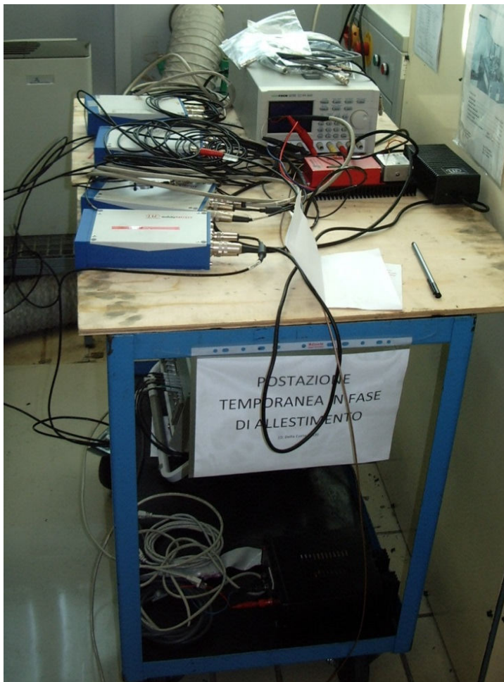
Abbildung 6.8: Wirbelstrommessgeräte, Stromversorgung und Telemetrieinheit
