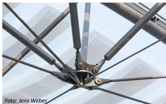
Abb. 2.05: Einsatzbereich von Zuggliedern am Beispiel der Überdachung des Carports der Abfallwirtschaft München [66]
