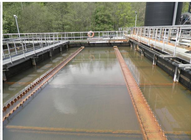
Abb. 3.21: Absetzbecken WBA Schlema-Alberoda
