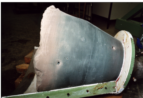
Ansicht des freigelegten Injektionskörpers
