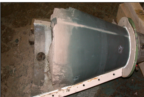
Ansicht des freigelegten Injektionskörpers
