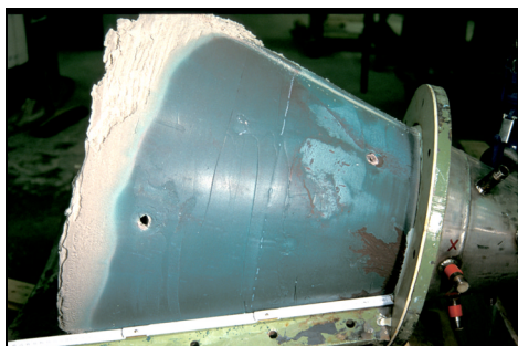
Ansicht des freigelegten Injektionskörpers
