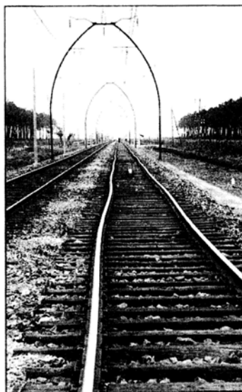
Abbildung 1: Verschiebung des Gleisrostes bei Hochgeschwindigkeitsversuchen der SNCF [78]
