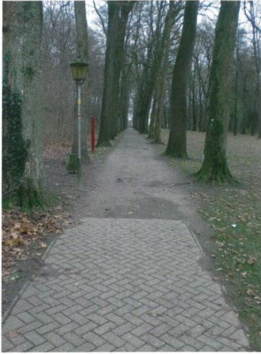
6 Weg auf der Nordseite der Sögeler Allee: Betonpflaster und wassergebundene Decke, Zustand im Jahre 2012.
