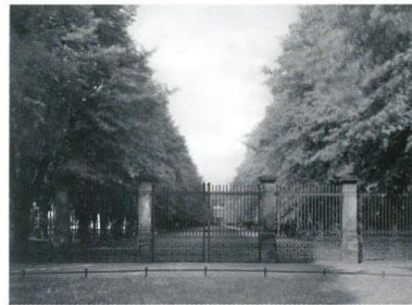
1 Die Lindenallee im Berggarten wahrscheinlich in den 20er Jahren des 20. Jahrhunderts, als sie auch noch als Mausoleumsallee bezeichnet wurde. Sie weist zu dieser Zeit eine mittlere Höhe auf.
