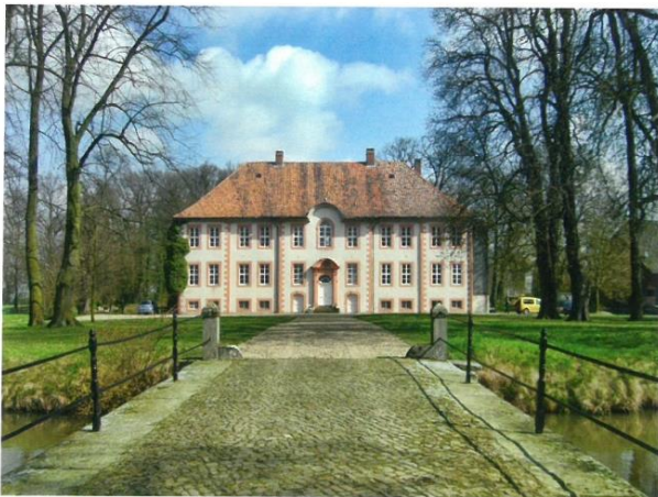
9. Haus Essenrode mit der Zufahrt und dem alten Baumbestand des Parks im Hintergrund, 2008
