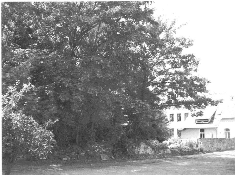
Abb. 20: Blick auf die nördliche Gartenmauer und das ehemalige Gärtnerhaus der Villa Löwenherz, 2006 (Foto: Rainer Schomann)
