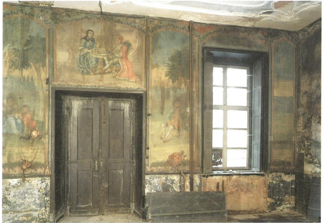
7 Wandmalereien der 2. Hälfte des 18. Jahrhunderts im Entree, Blick auf Wand mit Eingangstür, 1988.
