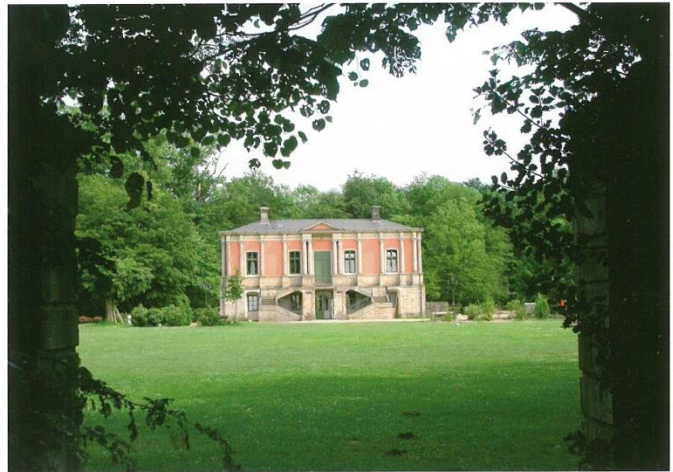
Abb. 4: Blick durch das ehemalige Haupttor auf die Eingangsfassade der Eremitage Baum, 2007.
