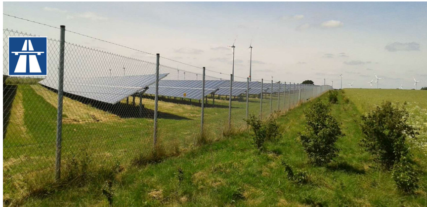
Abb. 59: Beispiel für die multifunktionale Gestaltung des Anlagenumfeldes (Anlage 25, Gerdshagen; das Verkehrsschild kennzeichnet die Lage der Autobahn). Zwischen Einzäunung und Acker wurde ein lückiger Gehölzstreifen (evtl. als Kompensationsmaßnahme) angelegt. Damit wurden potenzielle Habitatflächen sowohl für Offenland- als auch für Gehölzarten geschaffen. Da die übrige Landschaft zum Großteil von Ackerflächen geprägt ist, kann diese Maßnahme als sinnvoll eingestuft werden und eine Ergänzung zum Straßenbegleitgrün bilden. Dieses ist ebenfalls von lockeren Gebüschreihen geprägt, sodass der Aufbau einer heckenartigen Struktur entlang der PV-FFA vorstellbar ist.
