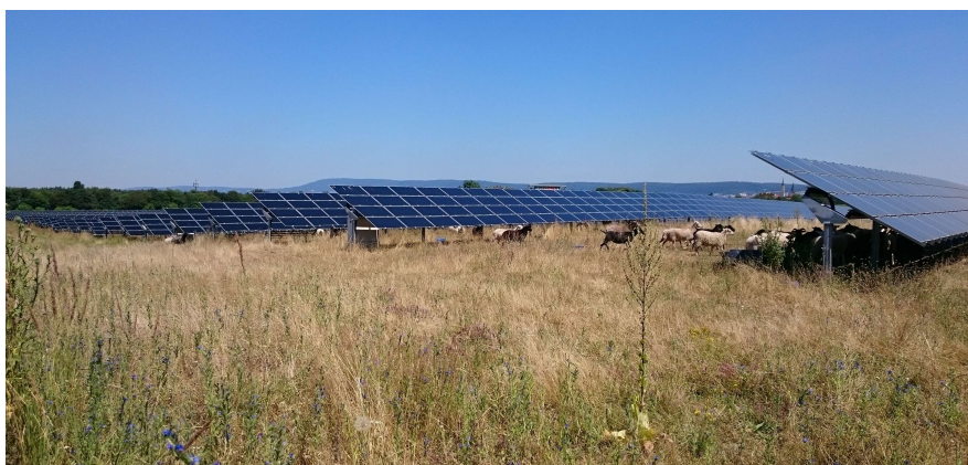
Abb. 65: Pflege einer PV-FFA durch Schafbeweidung (Anlage 135, Walldorf).
