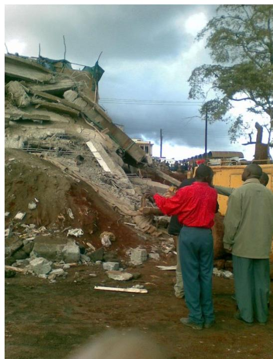
*Abb. 1.2: Eingestürztes Tragwerk während Bauphase*
