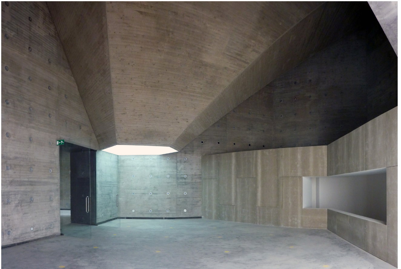
Abb. 44 Die Oberlichttrichter (schiefe, hexagonale Pyramidenstümpfe) wirken als Anziehungspunkte innerhalb der labyrinthischen Raumstruktur
