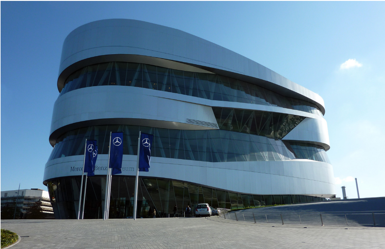
Abb. 19 Die modellierte Sockeloberfläche mit ihren Schrägen und Wölbungen leitet auf den Haupteingang des Gebäudes zu. Das Aluminiumband hebt sich hier an und öffnet das Gebäude nach außen. Krümmung und Kurvigkeit prägen die äußere Gestalt. Durch die glatte Materialität der Aluminiumverkleidung wird die geschmeidige Erscheinung der Formation noch stärker betont.
