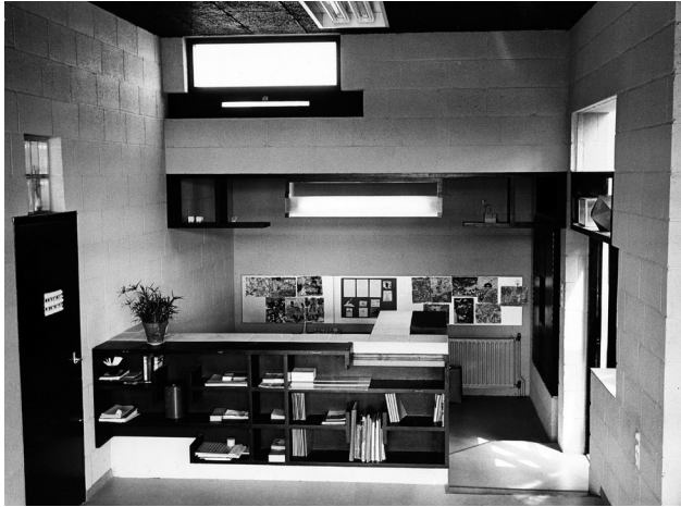
Abb. 05 Klassenraum: Kleinerer, nach unten versetzter Bereich, rechts Eingang
