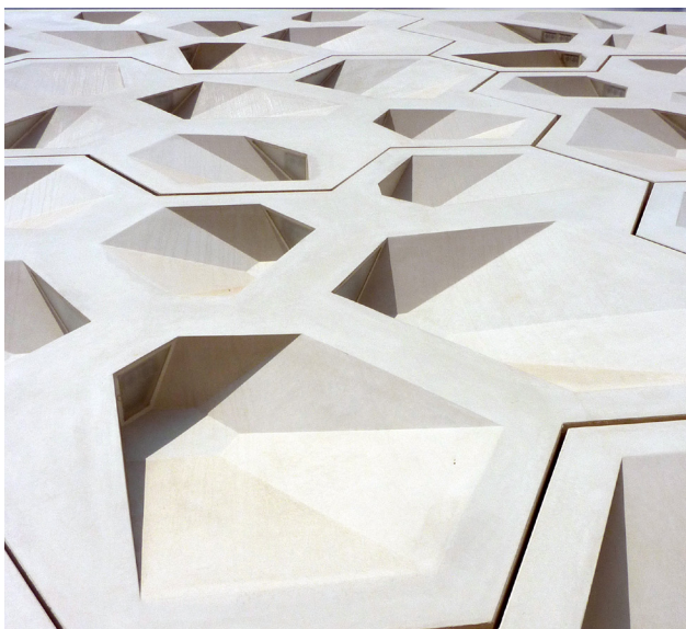
Abb. 35 Fassadenrelief: Schiefe, hexagonale Pyramidenstümpfe spiegeln die formale Idee des Inneren nach außen
