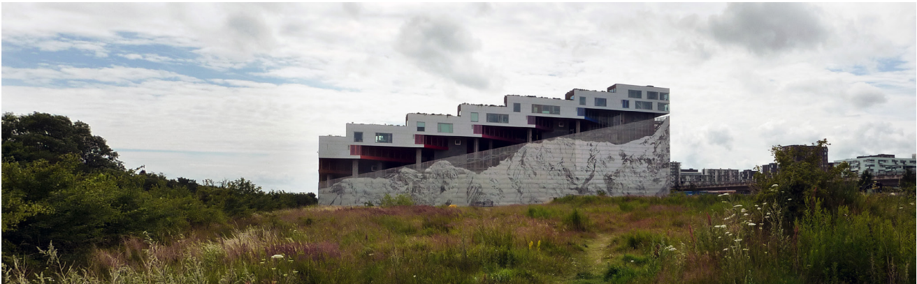
Abb. 30 Blick von Norden auf die Berggrafik des Parkhauses und die aufgesetzten Wohnmodule
