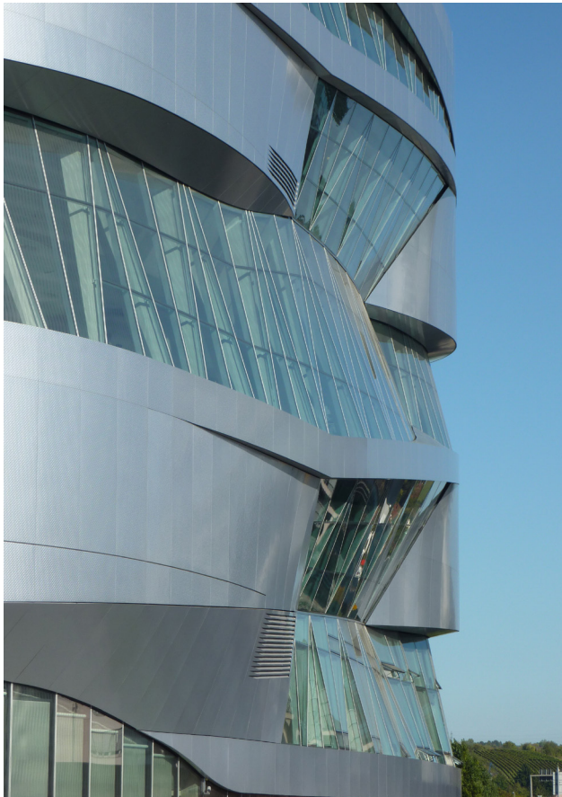
Abb. 21 Die Fassade zeigt das Prinzip sich überkreuzender Elemente: Glas- und Aluminiumbänder sind ineinander verschrankt und gliedern das Gebäude als horizontale Bänder.
