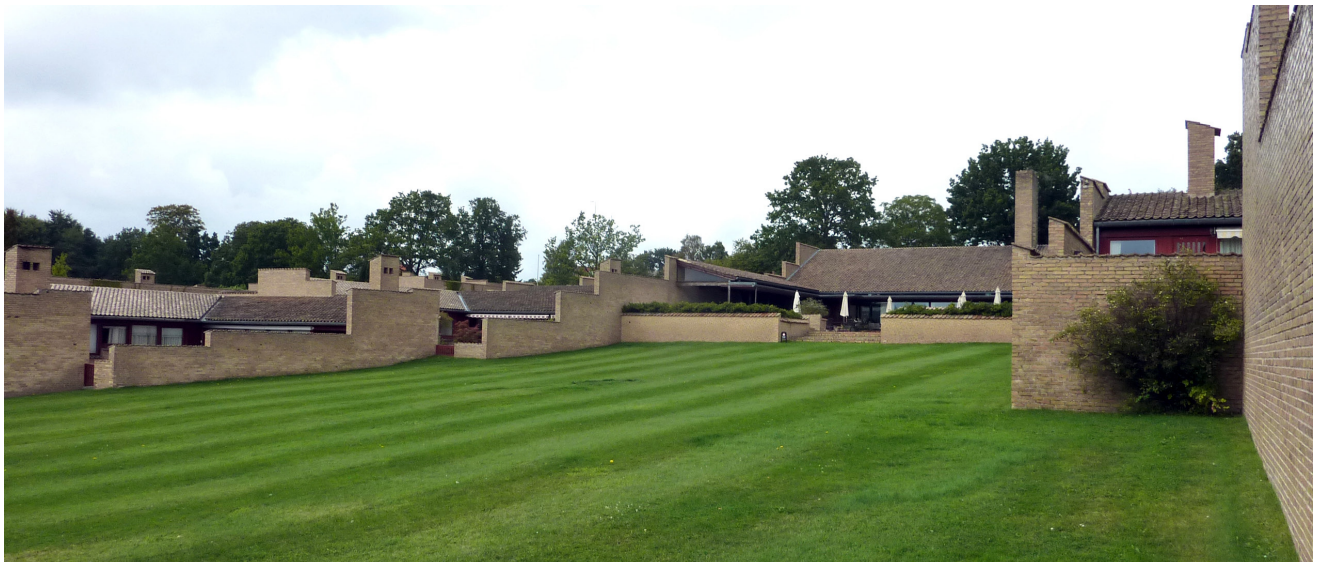
Abb. 05 Blick auf den Hang: Kollektiver Raum zwischen den Gebäuden, vielfältige Raumsituationen
