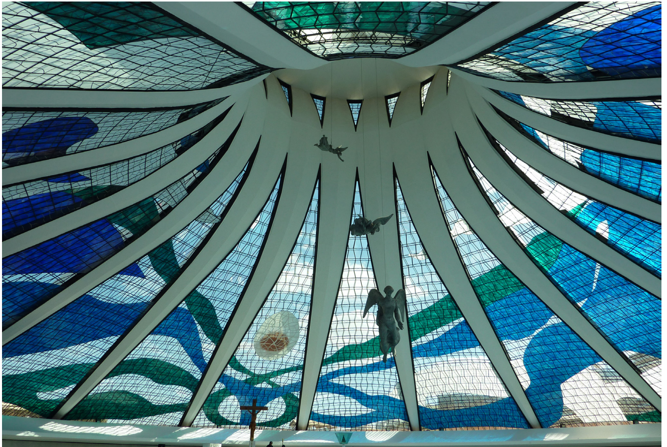
Abb. 10 Innenraum: Blick nach oben, frei geschwungene Motive der Glasmembran; Rotationssymmetrie der gekrümmten Betonrippen
