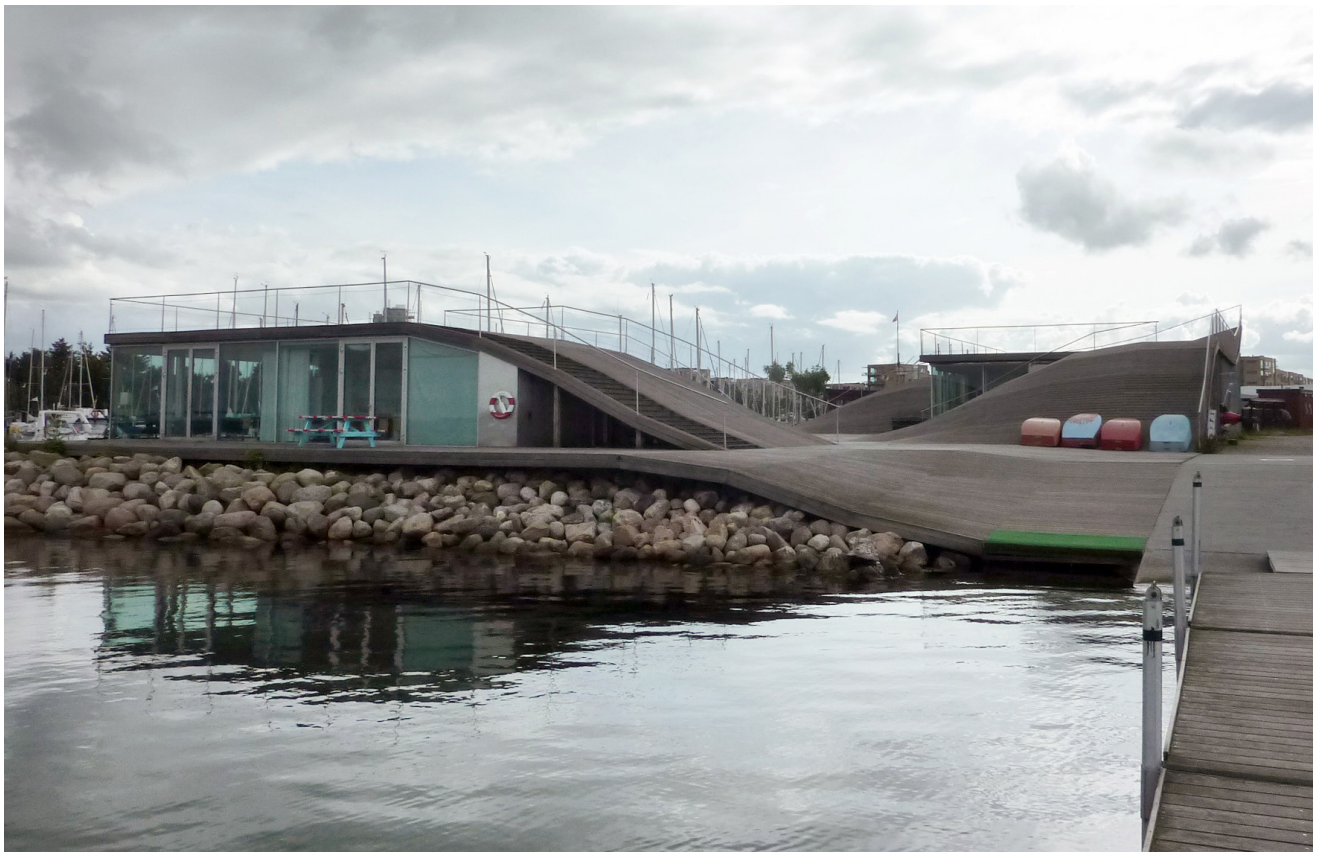
Abb. 01-03 Die hügelige Topografie bietet Lagerflächen unterhalb des hölzernen Decks und ist oberhalb als Spielfläche nutzbar.
