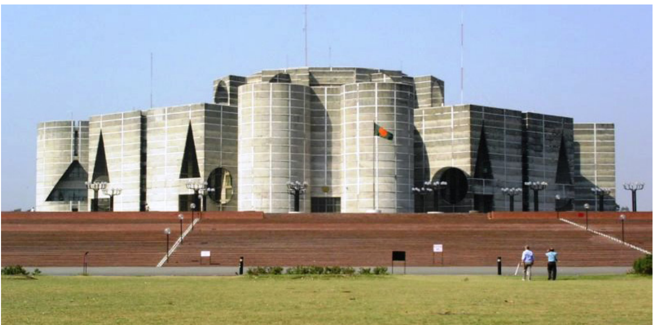
Abb. 04 Parlamentsgebäude, Ansicht Süd: Symmetrie und Axialität: Bruch durch den gedrehten Baukörper der Moschee; Fassade mit elementargeometrischen Öffnungen
