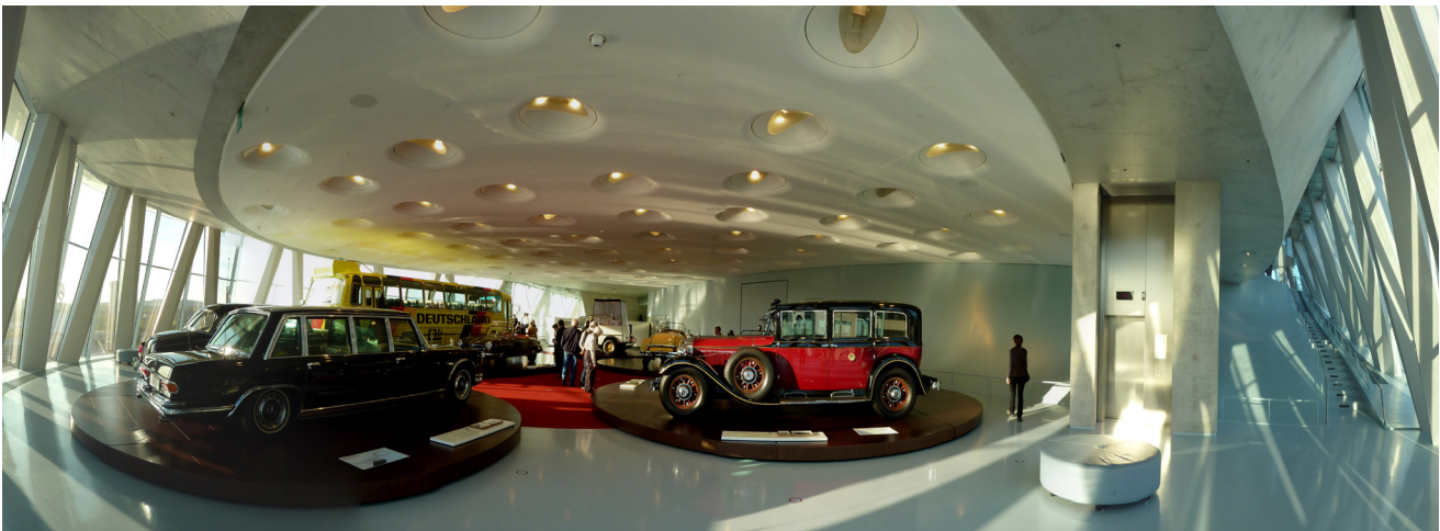
Abb. 40 Die Kollektionsräume sind hell und nach außen geöffnet. Sie ermöglichen Blicke in die Umgebung und werden tagsüber hauptsächlich natürlich belichtet. Der Raumeindruck wird durch die gekrümmte, transparente Glasfassade und die doppelt gekrümmte Betonfläche des Twists mit der Treppe geprägt.
