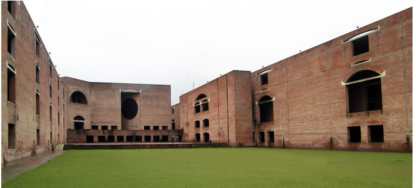
Abb. 01 Der Hof des Schulbereichs ist nach Westen geöffnet. Im Osten wird er durch den Bibliotheksbaukörper begrenzt. In der zentralen Achse steht die diagonale gestellte Wand des Bibliothekseingangs mit der kreisförmigen Öffnung; links davon befindet sich der diagonal gestellte Eingangsbaukörper.
