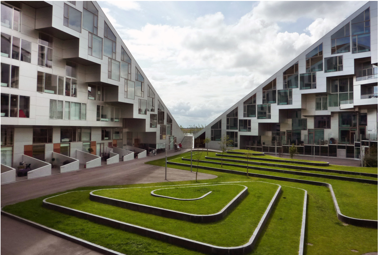
Abb. 22 Situationsvielfalt: Die vielgestaltige Architektur mit Auskragungen, Abtreppungen, Schichtungen, Schrägen, Brüstungen und Treppen formiert Bereiche mit unterschiedlichem Charakter und Eignung - eine suggestive Gestaltung, die zur Entdeckung und Adaption anregt.
