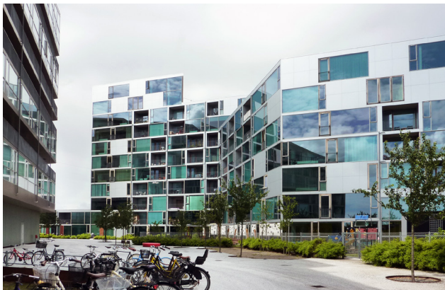
Abb. 09 Der mittige Hof, rechts das M-Gebäude, links das V-Gebäude
