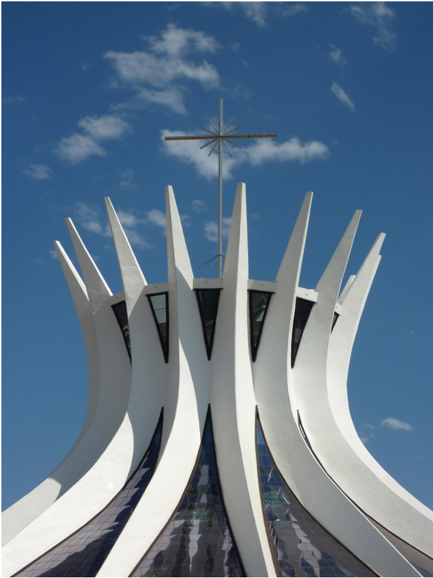
Abb. 08 Außenansicht des hyperbolischen Baukörpers
