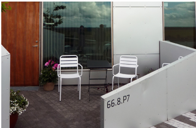
Abb. 25 ... Eingangssituation mit Terrasse.
