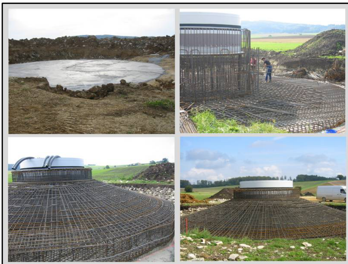
Abbildung 2.4 : Bauzustände bei der Herstellung eines Fundamentes
