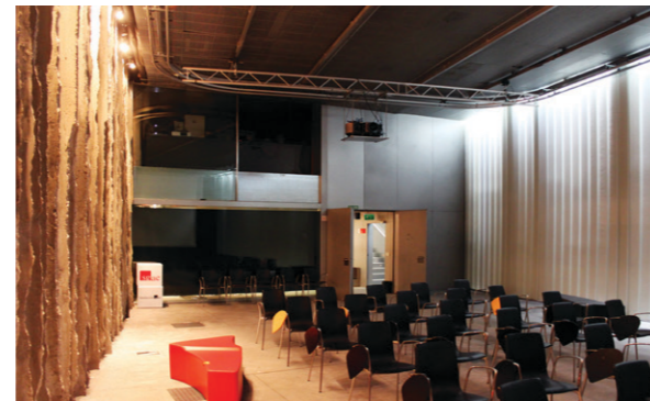
28 Gegenüberstellung der Wände im Untergeschoss: links Beton mit Baumabdrücken, rechts Industrieglas
