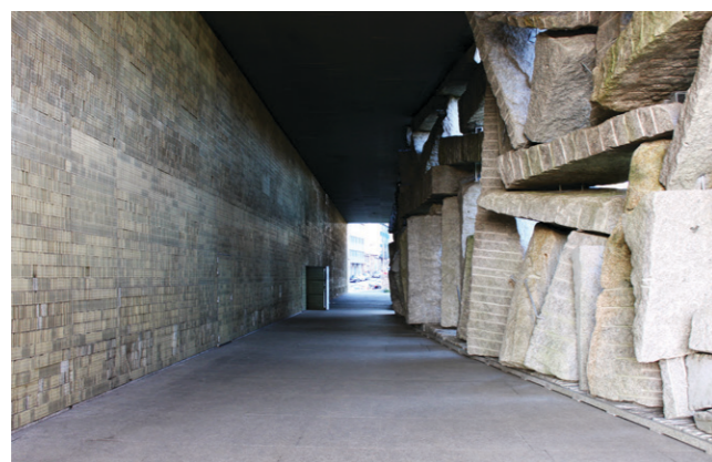
29 Gegenüberstellung der konstruktiven Systeme der zwei Wände im Portikus
