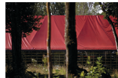
24 Habitación San Miguel, Chiloé 1992-1997 Zelt Dach über Raumgerüst
