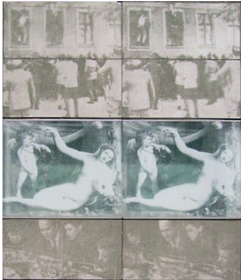
09 Herzog & de Meuron und Thomas Ruff Bibliothek Eberswalde 1999 Fassadendetail Fotografien auf Beton und Glaselementen als versinnbildlichtes Wissen
