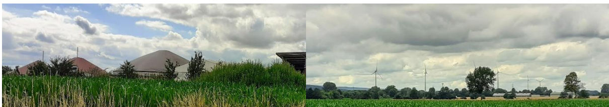
Abb. 82: Blick auf die Biogasanlage in Hohnhorst (eigene Darstellung 2021)
