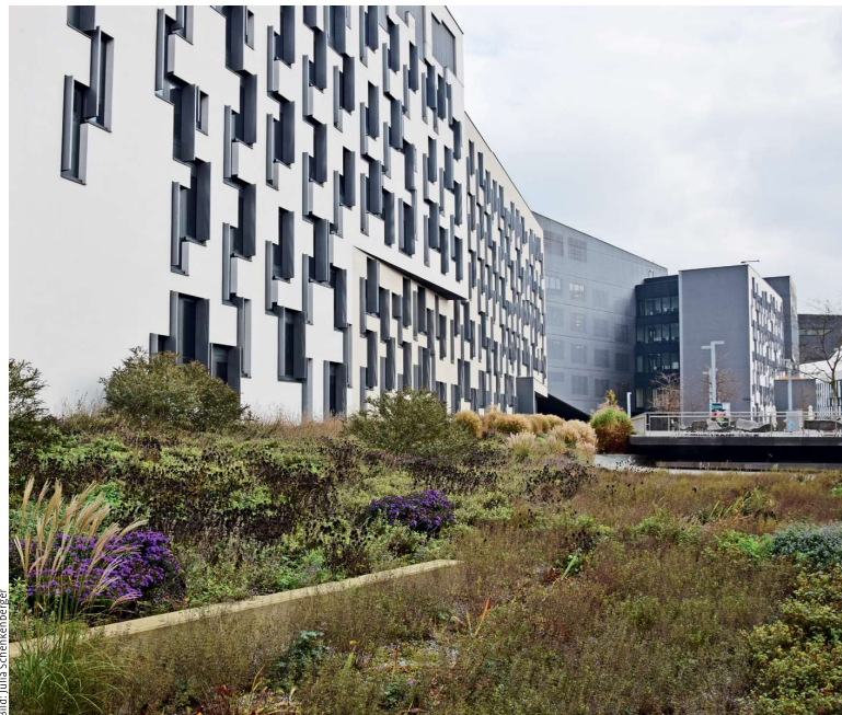
Abb. 6: Moderne Grüne Infrastruktur, hier auf dem Campus der Wirtschaftsuniversität in Wien, bietet vielfältige pflanzliche und bauliche Elemente.
