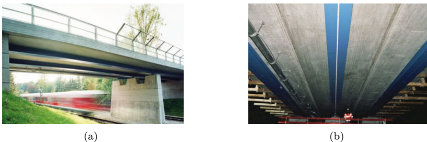
Abbildung 2.7: Brücke in Pöcking in VFT-Bauweise mit VDL in Klothoidenform: (a) Ansicht (Gündel et al., 2014), (b) Stahlträger des Verbundquerschnitts (Schmitt et al., 2004)
