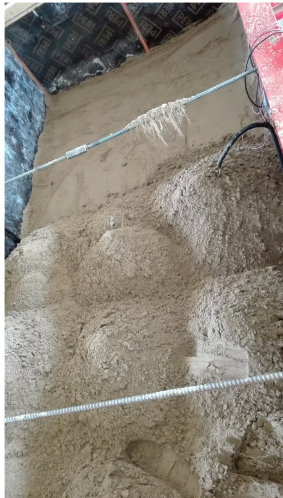
(b) Sand SE vor der Verdichtung
