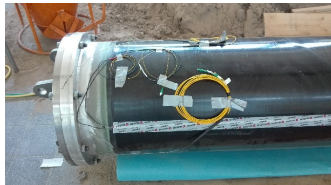
(d) Fertig verlegte Faser
